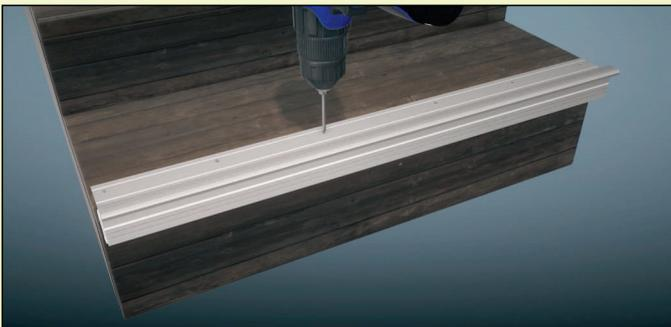
Schrauben Sie die Aluprofile mit ausreichend langen Senkkopfschrauben fest. Die Schraubenköpfe dürfen nicht über die angesengten Löcher vorstehen sondern müssen bündig abschließen. Bei Holztreppen ggf. mit einem 2 mm Bohrer kleine Löcher vorbohren.
