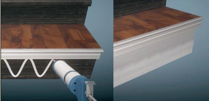
Bringen Sie auf der alten Stellstufe ausreichend Montagekleber auf, setzen Sie die neue Stellstufe ein und drücken Sie diese fest gegen die alte Stellstufe.
