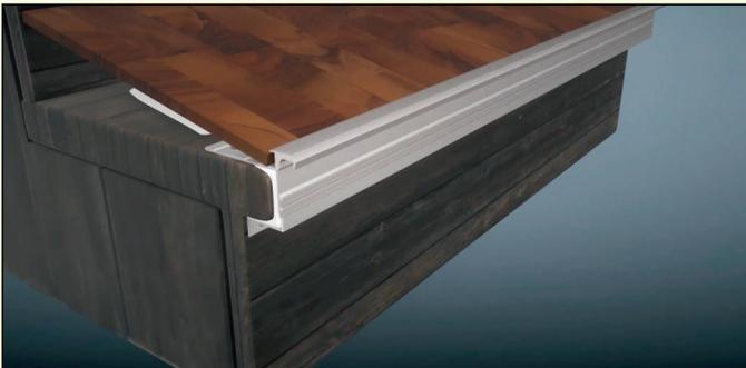
Setzen Sie jetzt die neue Trittstufe ein. Die Vorderkante der Trittstufe muss an der Aluschiene durchgehend gerade anliegen. Hinten kann ruhig ein Abstand von einigen Millimetern sein, da die neue Stellstufe diesen Zwischenraum dann abdeckt.
