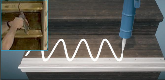
Bringen Sie auf der alten Trittstufe ausreichend Montagekleber oder bei durchgetretenen Trittstufen einen Montageschaum auf.
