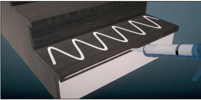
Bringen Sie jetzt auf der alten Trittstufe und Stufenvorderkante ausreichend Montagekleber auf.
