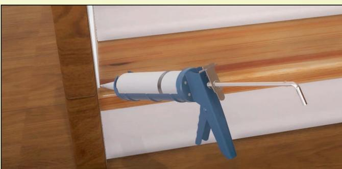
Zum Abschluss alle Fugen mit dauerelastischem Dichtstoff - passend zur Holzfarbe oder Wangenfarbe - verschließen.
