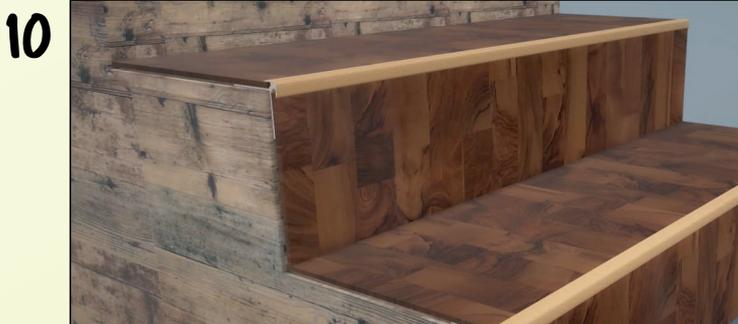
Setzen Sie die neue Stellstufe ein und drücken Sie diese fest gegen die alte Stellstufe.
