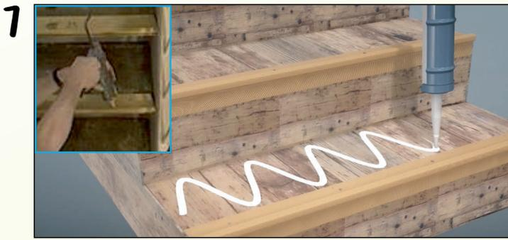
Bringen Sie auf der alten Trittstufe ausreichend Montagekleber oder bei abgenutzten Treppen einen leicht schäumenden Montageschaum auf.
