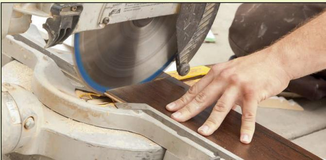
Messen und schneiden Sie die neue Trittstufe zu. Wenn die Trittstufe aus mehreren Dielen besteht verkleben Sie diese miteinander.
