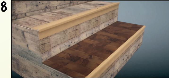
Setzen Sie jetzt die neue Trittstufe ein. Die Vorderkante der Trittstufe muss an der Aluschiene durchgehend gerade anliegen. Hinten kann ruhig ein Abstand von einigen Millimetern sein, da die neue Stellstufe diesen Zwischenraum dann abdeckt.
