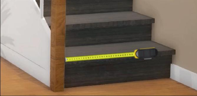
Messen Sie alle Treppenvorderkanten genau ab und notieren Sie sich alle Maße auf einem Zettel.
