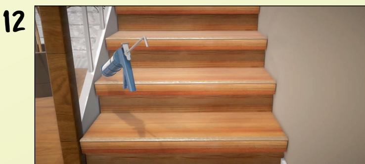
Zum Abschluss alle Fugen mit dauerelastischem Dichtstoff - passend zur Holzfarbe oder Wangenfarbe - verschließen.
