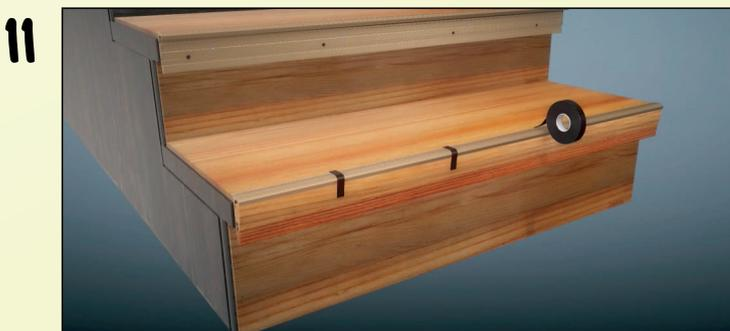
Setzen Sie die Holzblende ein und drücken diese fest gegen das Aluprofil. Zum Fixieren bis der Montagekleber angezogen hat können Sie die Holzblende mit Klebeband oder Klemmzangen fixieren.
