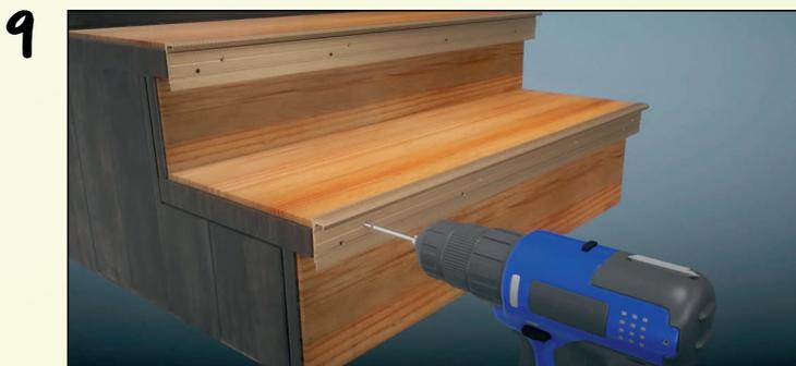
Setzen Sie das Aluprofil auf. Austretendes Silikon schnell entfernen (Wasser mit Spüli).
