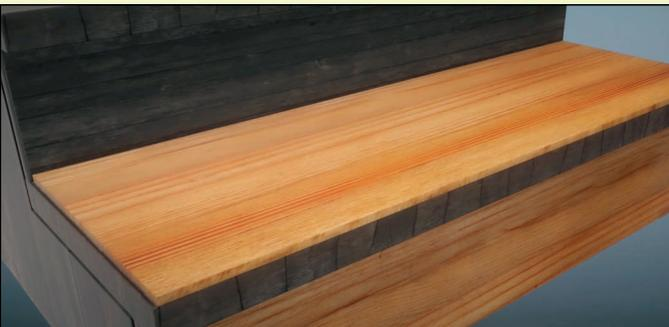
Setzen Sie jetzt die neue Trittstufe ziemlich Bündig mit der Vorderkante der alten Stufe auf. Die neue Trittstufe darf nicht über die alte Trittstufe stehen.
