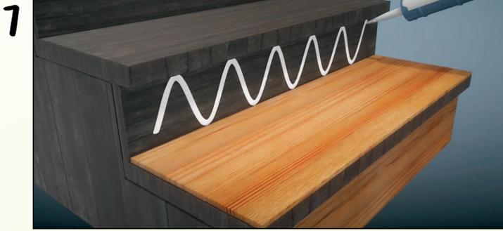
Bringen Sie auf der alten Stellstufe ausreichend Montagekleber auf, setzen Sie die neue Stellstufe ein und drücken Sie diese fest gegen die alte Stellstufe.
